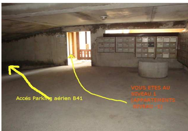
14 Accès Parking aérien B 41
